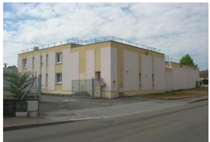
Bâtiments d'activités de 704m 2 sur un terrain de 3 614m 2 à Chaumont, Source : Agglomération de Chaumont,
