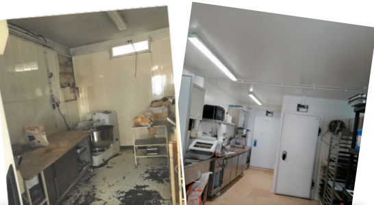
Création d'une chambre froide pour la boulangerie L'Abbatiale à Arc-en-Barrois
